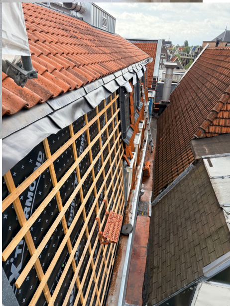
Een kijkje in de woningen, en boven op het dak aan de Warmoesstraat 66.
