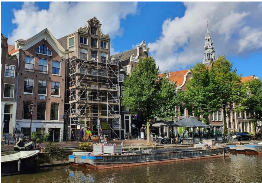
De aan- en afvoer van bouw materiaal en –afval vindt plaats over het water bij de realisatie van project Oudezijdsvoorburgwal 136
